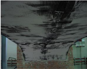
Consolidamento dell'intradosso con rete in CFRP bidirezionale
