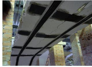
Consolidamento dell'intradosso con fasce in CFRP
