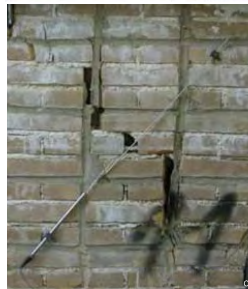
Figura 14: provini sottoposti a prova a taglio nel caso “non consolidato” (a), applicazione di rinforzo localizzato nei giunti orizzontali “RO” (b) e rinforzo con disposizione “a reticolo”, “RR” (c).
