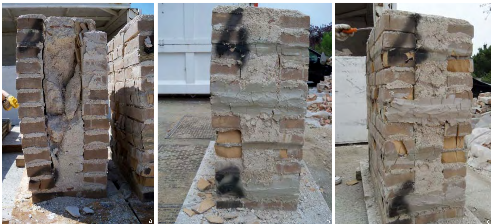
Figura 12: provini di muratura “a sacco” dopo la prova a compressione: i “non consolidati” (a) presentano le cortine esterne vistosamente deformate e distaccate dal nucleo centrale al contrario di quelli consolidati con TICORAPSIMO® “RO” (b) e “RR” (c)
