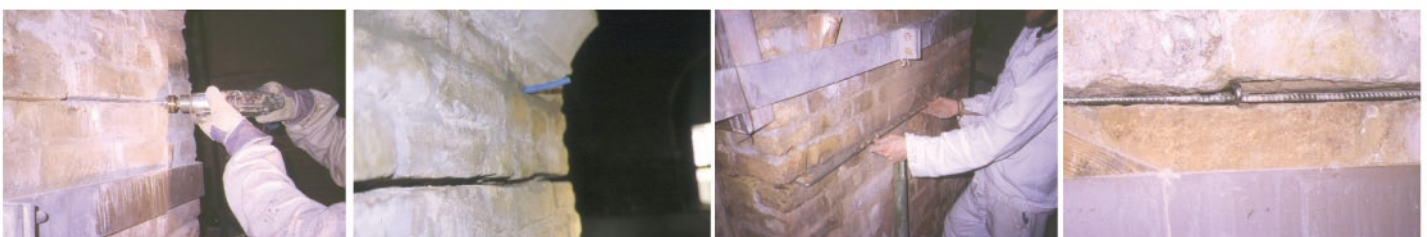
Applicazione di barre al carbonio nei giunti di malta
