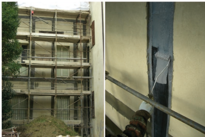
Repointing orizzontale e verticale di pareti in muratura con tessuti in C-FRP
