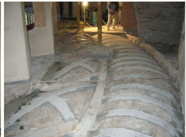
Rinforzo di voltini in muratura con tessuti in fibra d'acciaio
