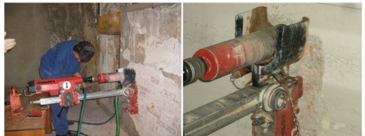
Esecuzione di carotaggio
